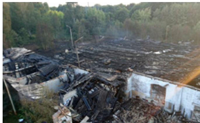
Nur noch verkohlte Trümmer: Die ehemaligen Lagerhallen der alten Furnierfabrik
