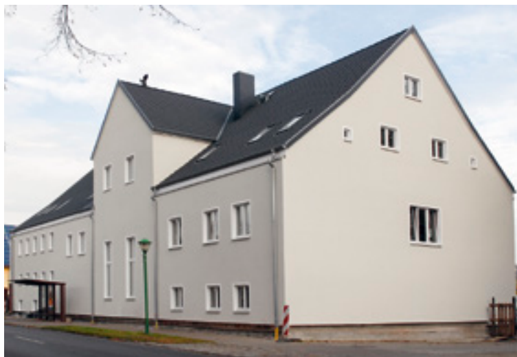
Nach allen Regeln des Denkmalschutzes (das Erscheinungsbild der Nachbargebäude durfte nicht „gestört“ werden) vom neuen Eigentümer saniert: Die alte Brennerei in neuem Glanz
